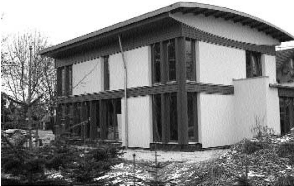
**Lehmbauhaus:** Fertig vorbereitete Außenwände mit 60 mm Inthermo Putzträgerplatte, Holzrahmenbaukonstruktion aus KVH 6/20 im Raster 81,5 Zellulosedämmung, OSB 18 mm innenseitig, Deckenuntersicht OG mit ausgebildeter Segmentbogenkrümmung, Installationsflächen Innen vorbereitet für Lehmbauschaale, alle tragenden Innenwände beplankt mit OSB, inkl. Blower-Door-Test, inkl. Einrüstung
